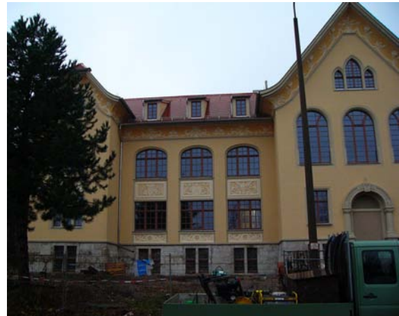
Bild 2: Max-Zöllner-Villa in Weimar während der Sanierung
