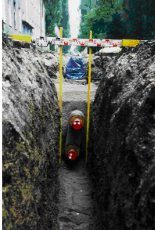
Bild 4 + 5: Fernwärmetrasse übereinander verlegt und mit WBM eingegossen
