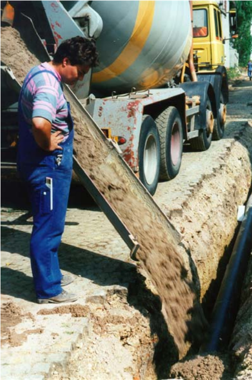
Bild 4 + 5: Fernwärmetrasse übereinander verlegt und mit WBM eingegossen
