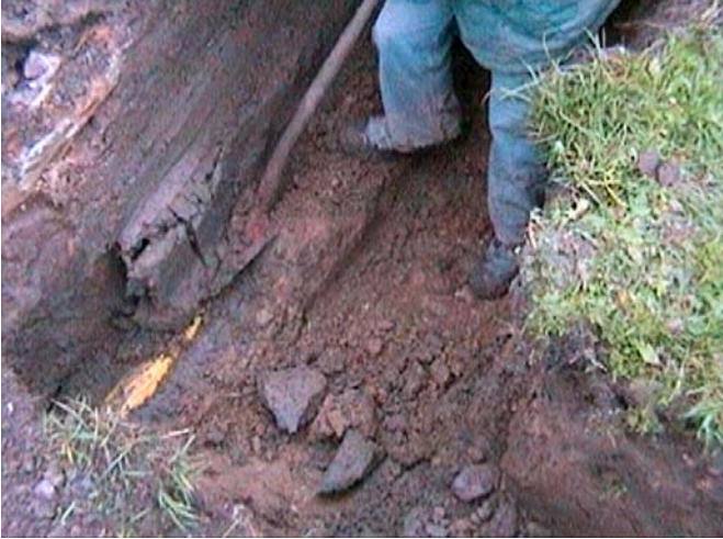
Bild 7: Aufgrabung Trasse Tonndorf-Nauendorf nach 5 Jahren
