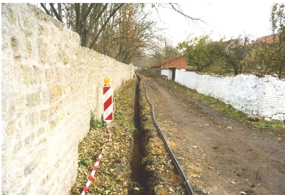
Bild 7: Leitungsgaben und vorbereiteter Verbund aus drei Starkstromkabel vor dem Ablegen auf die Grabensohle aus Sand
