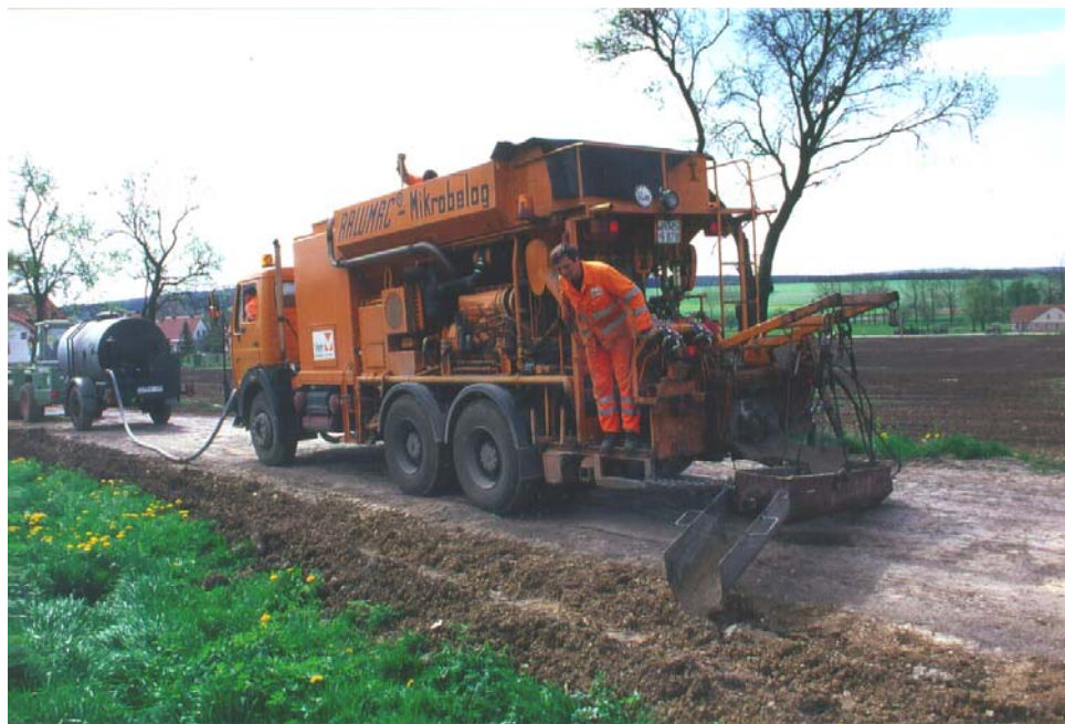
Bild 3: Feldversuch Tonndorf, Gasversorgung Thüringen, Herstellung und Einbau von Boden-Mörtel mit einer Schlammmaschine
