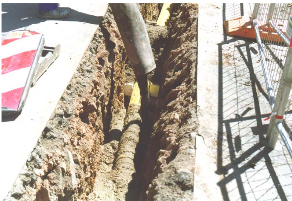
Bild 10: Verfüllen der Leitungszone mit Boden-Mörtel
