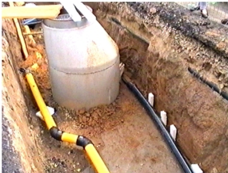
Bild 4: Blick in den teilverfüllten Rohrgraben nach abgeschlossener Einbettung der Abwasserleitung in Sand und der ersten Schicht WBM ® mit aufliegender Gas- und Wasserleitung im Bereich eines Abwasserschachtes
