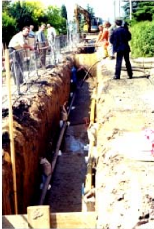
Bild 5: Blick in den Rohrgraben zu Beginn der Verfüllung der 2. Schicht mit Weimarer Bau-Mörtel®
