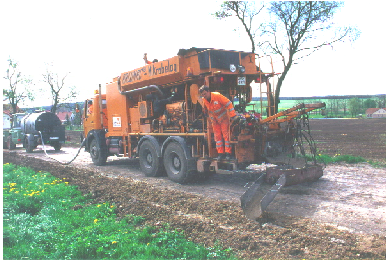
Bild 3: Feldversuch Tonndorf, Gasversorgung Thüringen, Herstellung und Einbau von WBM ® mit einer Schlammemaschine
