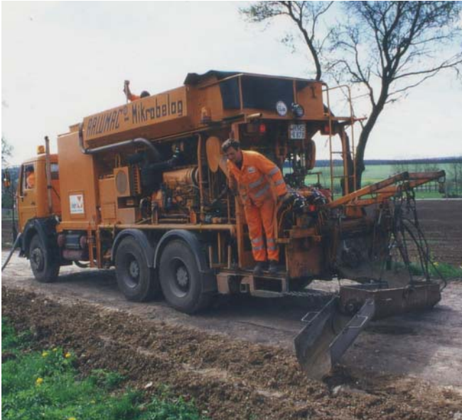
Bild 3. Schlammemaschine für die Herstellung von WBM an der Baustelle.
