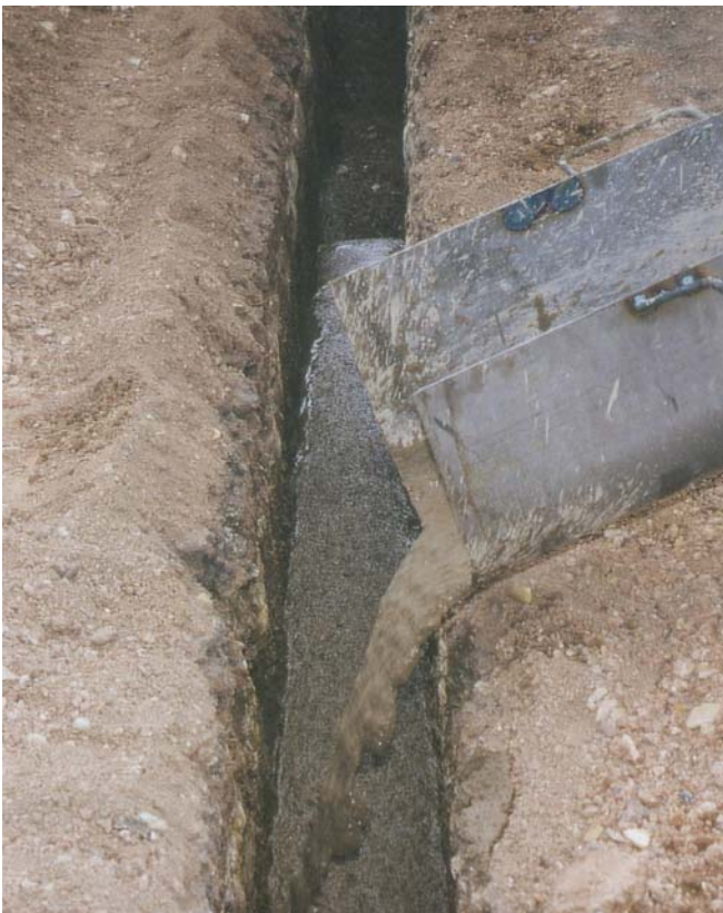
Bild 4. WBM-Verfüllung an der Versuchsbaustelle „Tonndorf“ in der Nähe von Weimar.
