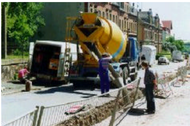
Bild 3: Anwendung des Weimarer Bau-Mörtels ® im Innenstadtbereich
