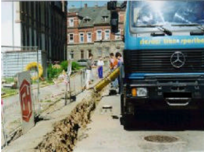
Bild 4: Einfüllen des Weimarer Bau-Mörtels® in den Leitungsgraben
