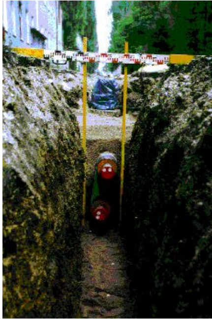
Bild 2: FW-Übereinanderverlegung, mit Weimarer Bau-Mörtel ® verfüllt
