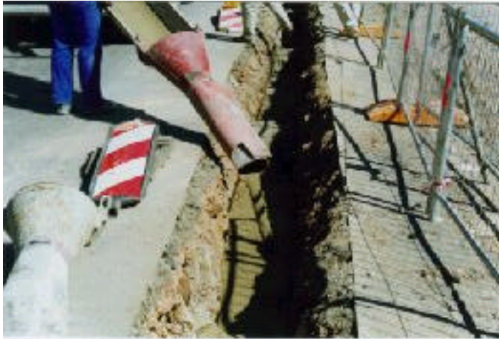
Bild 5: Detail (Einfüllen des Materials)
