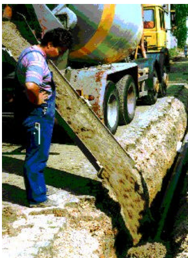
Bild 1: Verfüllen mit Weimarer Bau-Mörtel
