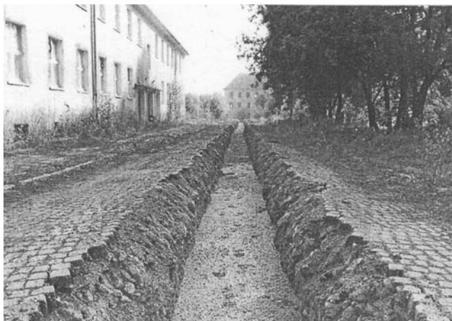
Bild 6. Fertiggestellte Leitungszone für Fernwärmeleitung gem. Bild 5.
