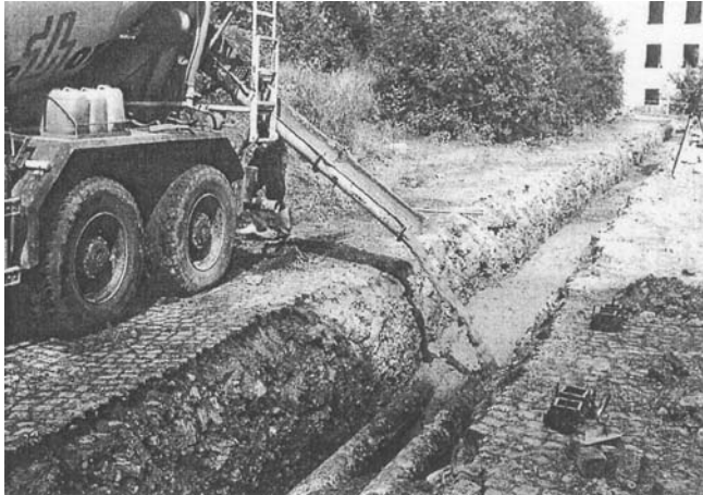
Bild 5. Einfüllen des Boden-Mörtels in den Leitungsraben einer Fernwärmeleitung 2 x DN 150 in Nebeneinanderlage.
