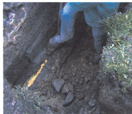
Aufgrabung Trasse Tonndorf-Nauendorf nach 5 Jahren
