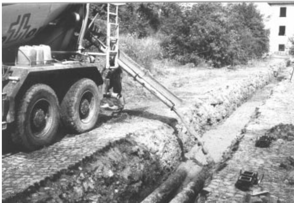
Bild 1: Feldversuch Stadtwerke Weimar, Lützendorfer Str., Einbau von Boden-Mörtel in die Leitungszone einer Fernwärmeleitung KMR 2 x DN 150 in Nebeneinanderverlegung
