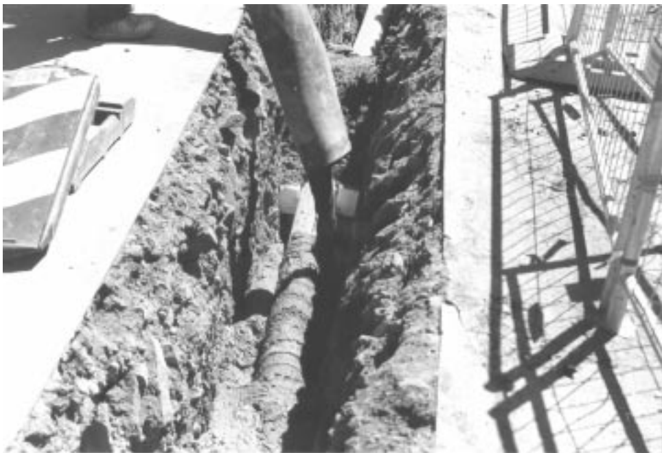
Bild 10: Verfüllen der Leitungszone mit Boden-Mörtel
