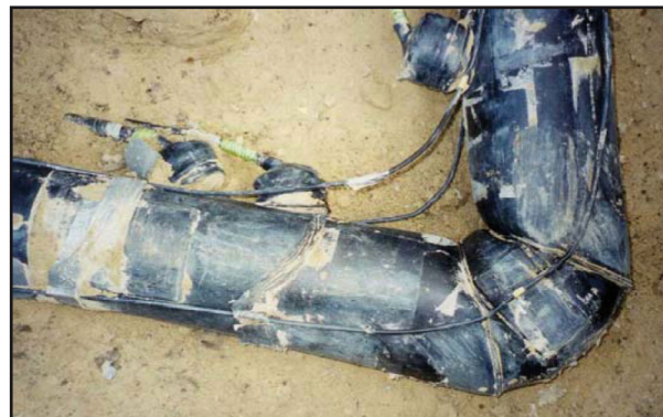
Zustand des beanspruchten Rohrbogens nach Abschluss des Grenzzustandsversuches
