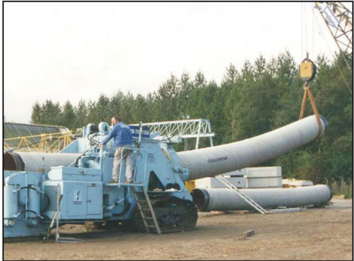
Kaltbiegen der faserzementmörtelumhüllten Stahlrohre
