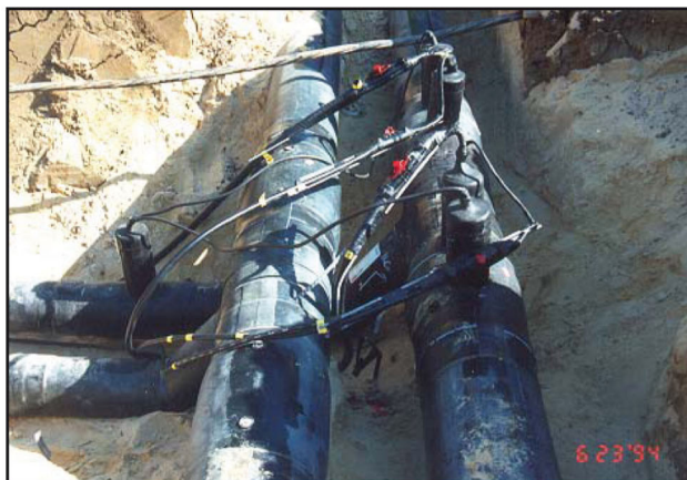
Proband im Rohrgraben
