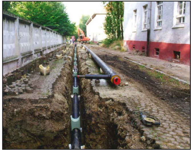
Übereinanderverlegung vor der Montage
