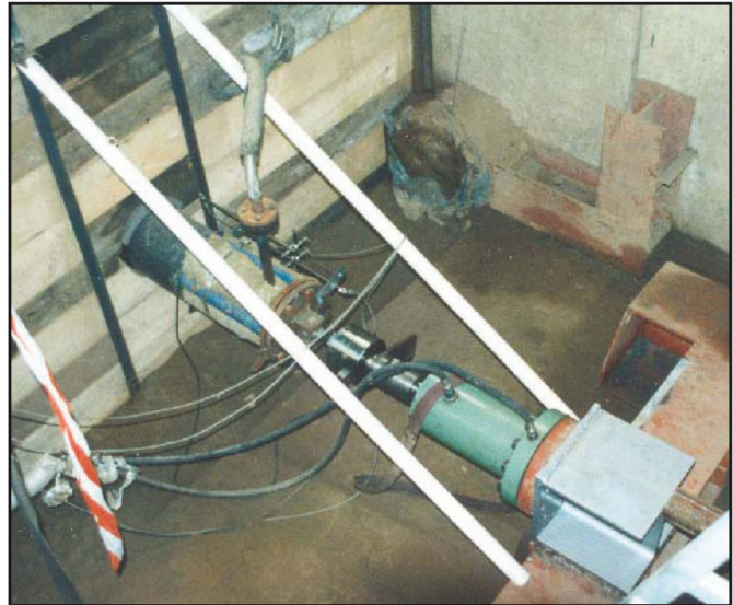
Blick in die Pressgrube
