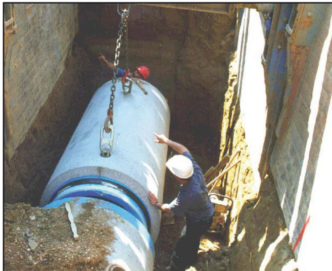
Absenken eines Beton-Rohres in den Graben
