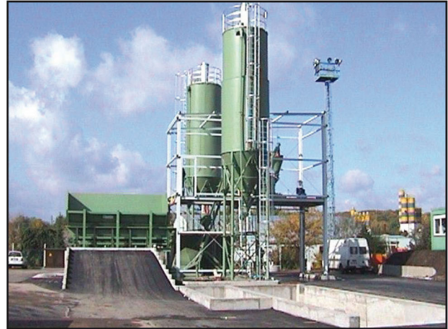
Pilotanlage für Boden-Mörtel in Erfurt
