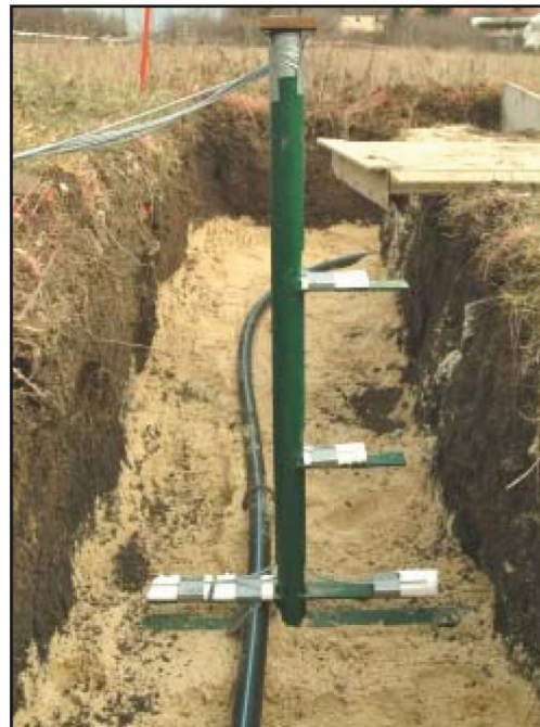
Aufbau der Versuchsstrecke
