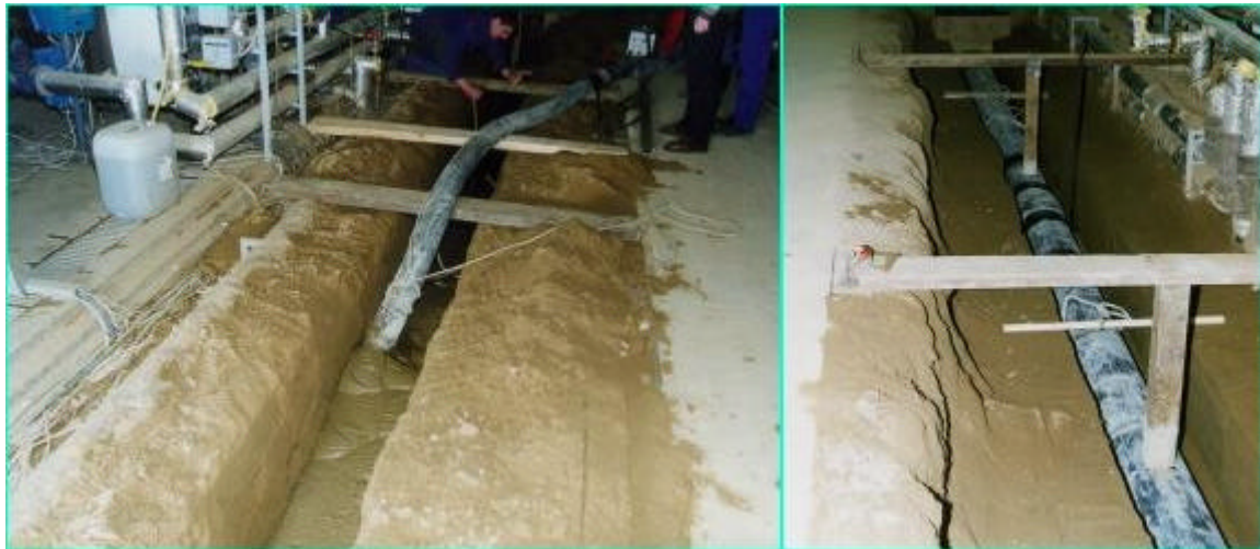
Auftriebssicherung des Probanden und Verfüllung des Grabens mit WBM(R)
