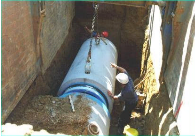
Absenken eines Intelpipe-Rohres in den Graben
