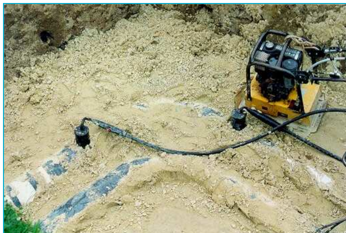
Proband im Rohrgraben
