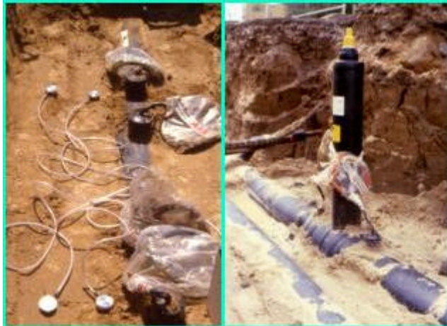
Probanden mit Messtechnik im Rohrgraben
