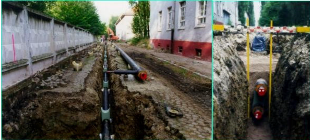
Übereinanderverlegung vor der Montage (links) und im Einbauzustand (rechts)
