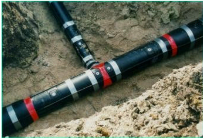
Probend im Rohrgraben
