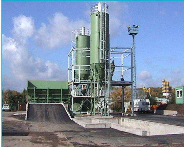
Pilotanlage für Boden-Mörtel in Erfurt
