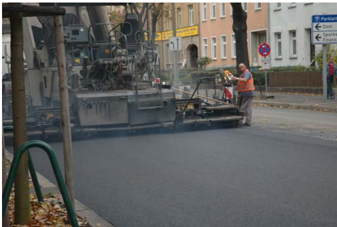
Abb. 3: Einbau des neuartigen Asphalts in der Erfurter Blumenstraße [Quelle: FITR]
