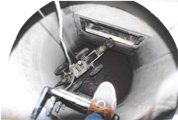
Bild 5: Kamerabefahrung
