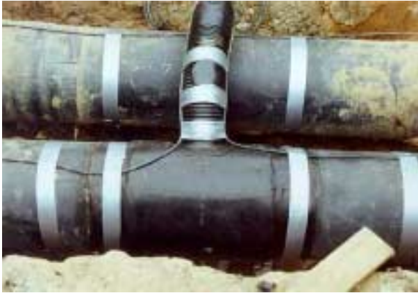
Bild 2: Anordnung der Lichtwellenleiterkabel zur Temperaturmessung
