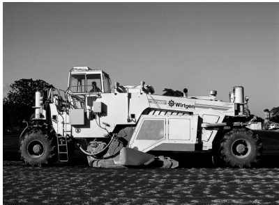
Bild 1: Maschine für Ortsmischverfahren (Site-mixing)
