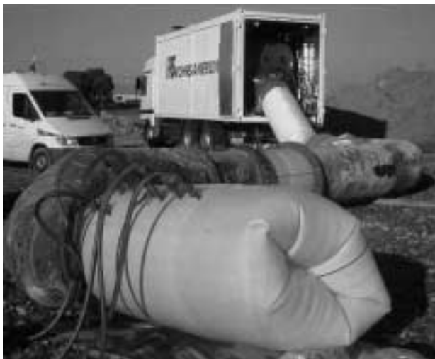
Bild 6: Process-Phönix-Installation, Trinkwasser, DN 1000 (bis max. 220 m)
