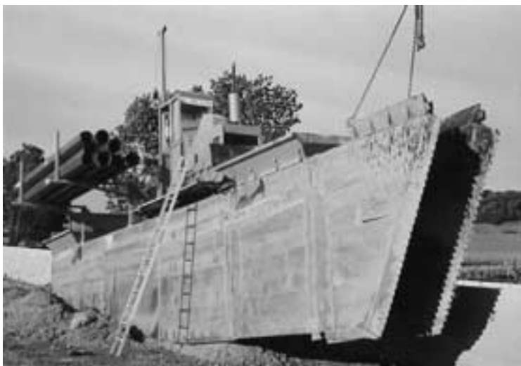
Bild 2: Verbausystem des PLR-Verfahrens [5]
