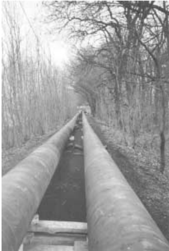
Bild 1: Interimsentwässerung
