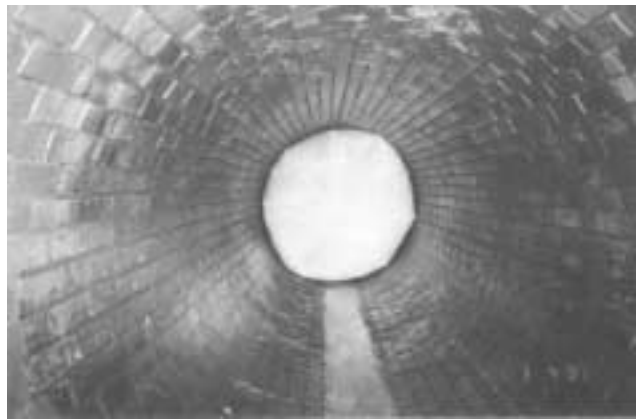
Bild 2: Einbau Preliner
