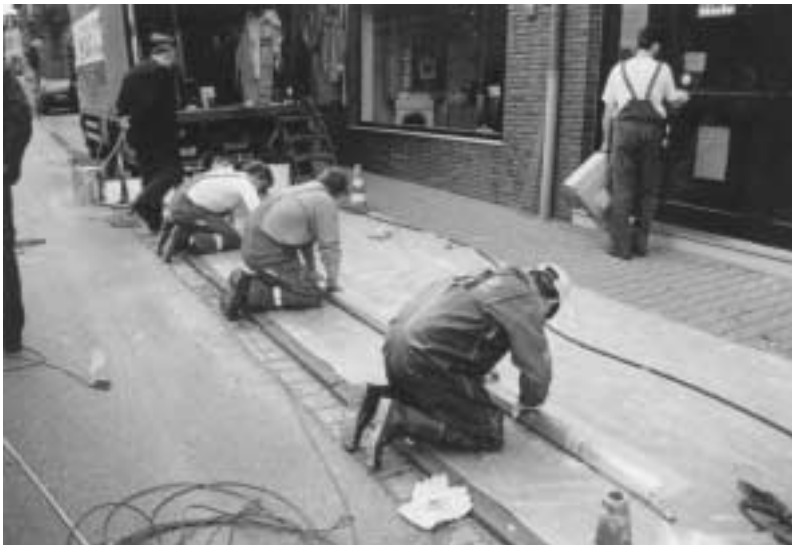
Bild 3: Arbeiter bereiten die nächste Hausanschlusssanierung vor
