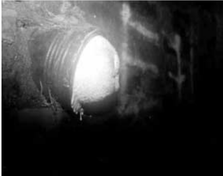
Bild 4a: Rohr-im-Rohr-Sanierung
