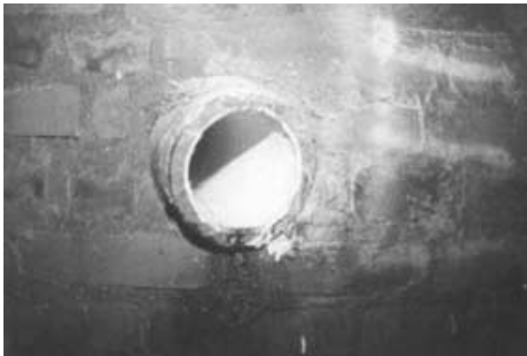
Bild 4b: Liner bündig abgeschnitten
