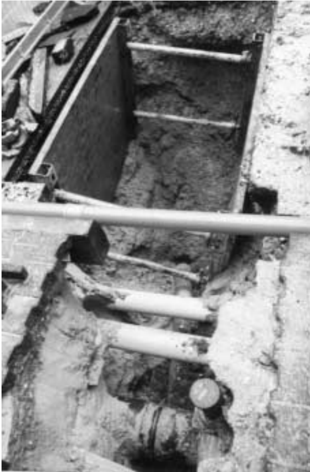
Bild 5: Problem „querende Leitungen bei offener Bauweise“
