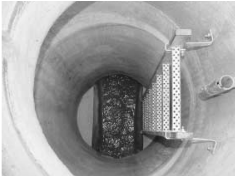
Bild 1: Von Hand aufgetragene Beschichtung aus mineralischem Mörtel
