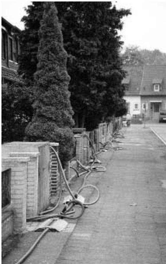
Bild 4: Aufrechterhaltung der Anliegerversorgung während der Rohr-sanierung
