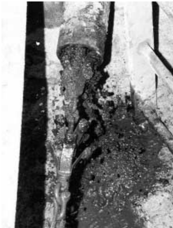
Bild 2: Mechanische Reinigung mit Kratzern, Gummischiebern und Bürsten
