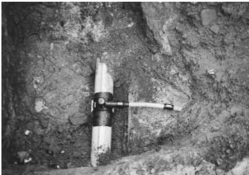
Bild 6: Nach erfolgtem Berstvorgang installierter Hausanschluss
