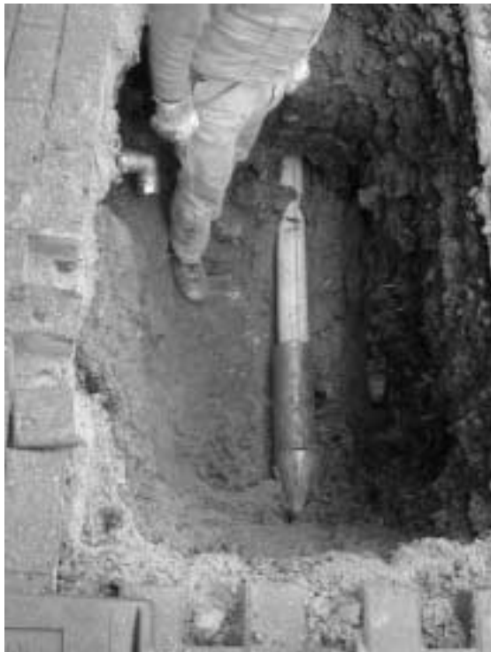
Bild 4: Durchfahung eines Kopfloches im Hausanschlussbereich
