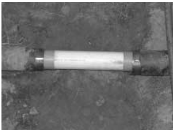
Bild 13: Nachträgliches Anbringen von neuen Hausanschlussleitungen
