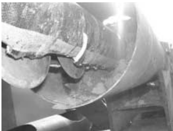
Bild 9: Scharfkantige Schnittflächen beim herkömmlichen Auftrennen von duktilen Gussrohren
