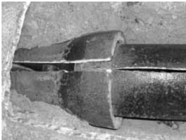
Bild 11: Sauberes Schneiden und Aufweiten von duktilen Gussrohren mit dem modifizierten hydros ® STEEL-Verfahren
