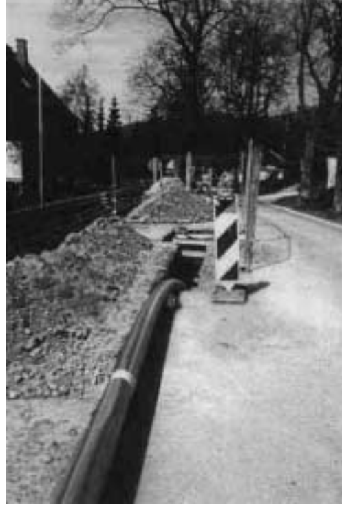
Bild 2: Einzug eines PE-Rohrstranges DN 300 in die Baugrube
