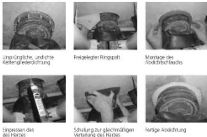
Bild 1: Vorgehensweise bei der Instandsetzung einer Nahwärmerohreinführung Quelle: Fraunhofer UMSICHT
