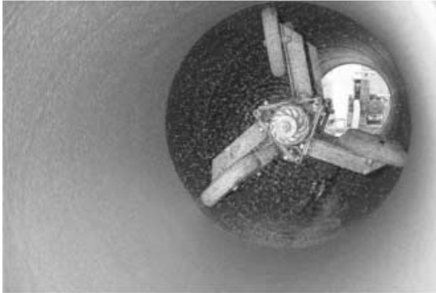
Bild 4: THUECON 2 - Schleuderkopf im Rohr
