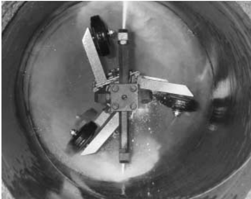
Bild 2: Rotierende Reinigungsdüsen im Rohr
