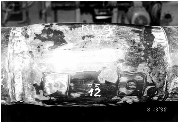
Bild 4: Zustand der Schrumpfmuffe des ersten KMR-Probanden DN 150 in 9-12-Uhr-Position (Position in Preßrichtung gesehen) nach insgesamt 337 Verschiebezyklen über jeweils 75 mm in Weimarer Bau-Mörtel ®
