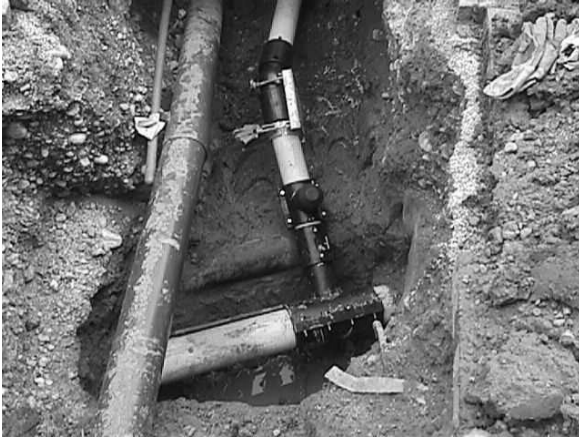
Bild 3: Die fertiggestellte Einbindung in kleinstmöglicher Baugrube
