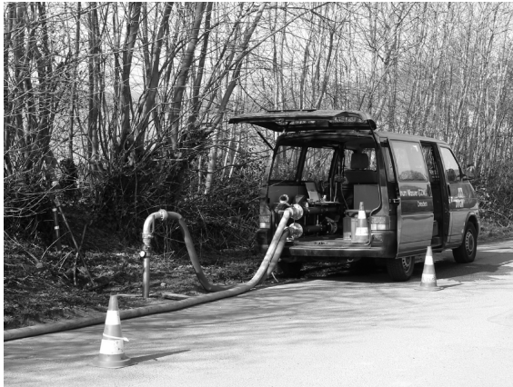
Bild 1: Netzspülung mit Erfassung der Ablagerungssituation
